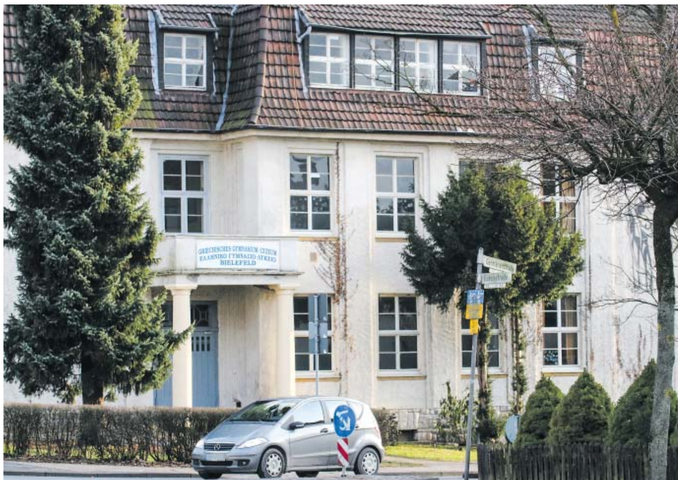
Steht seit einigen Tagen leer: Die Heizung der ehemalige Real- oder Mittelschule Brackwedes ist irreparabel defekt, die griechischen Schüler müssen kurzfristig in die ehemalige Förderschule am Kupferhammer umziehen.
